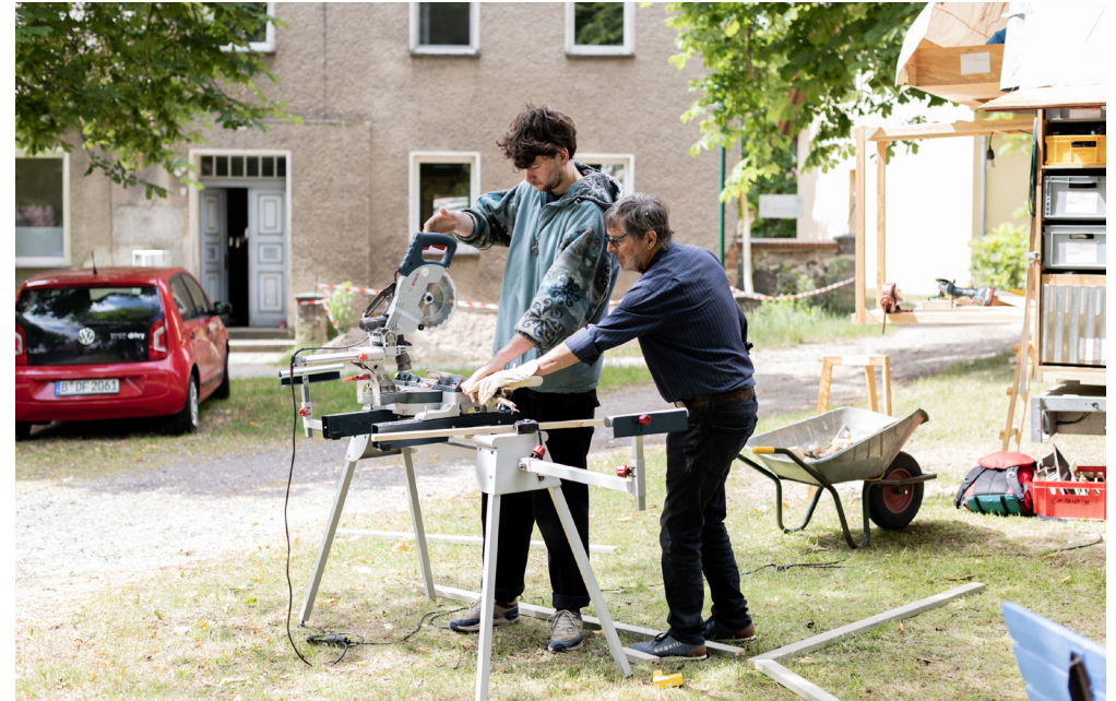
DIE NEUEN AUFTRAGGEBER VON STEINHÖFEL _ Die Auftraggebergruppe installiert den mobilen Treffpunkt der Künstlergruppe Constructlab. © Andries De Lange, 2022
